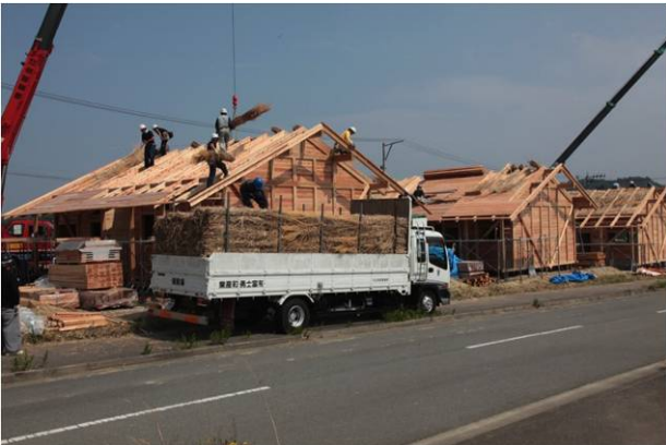
仮設住宅の屋根の断熱材に茅をつかう（福島県いわき市）
