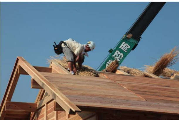
化粧野地と野地板の間に断熱材として茅を入れる
