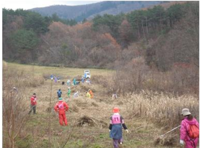
樹林化エリアの作業の様子
