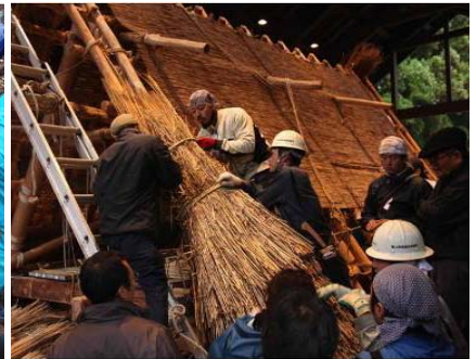
茅葺き技能研修 破風を葺く
