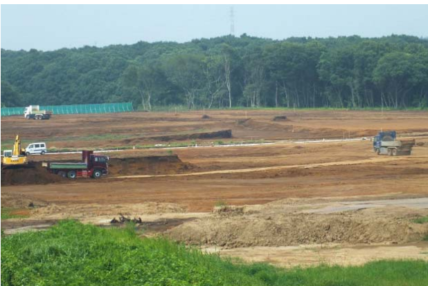
ニュータウンでの大規模な造成工事
