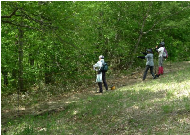
電気柵ケーブル敷設作業
