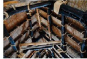
ススキ(屋根の内側)
