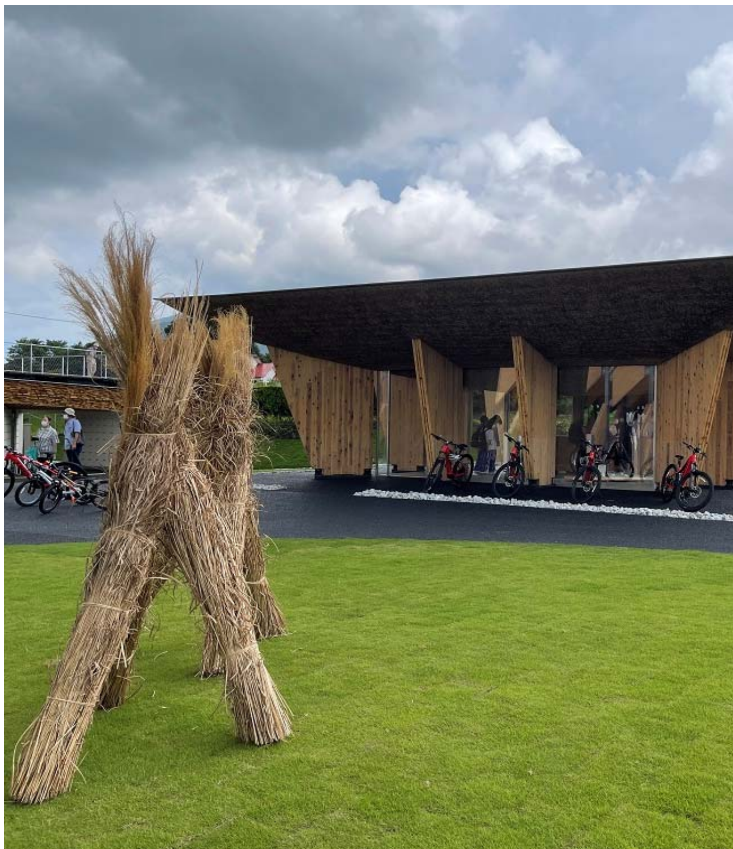
真庭市に新設されたサイクリングセンター。蒜山草原の茅が軒下などに使われている。(増井太樹氏撮影)
