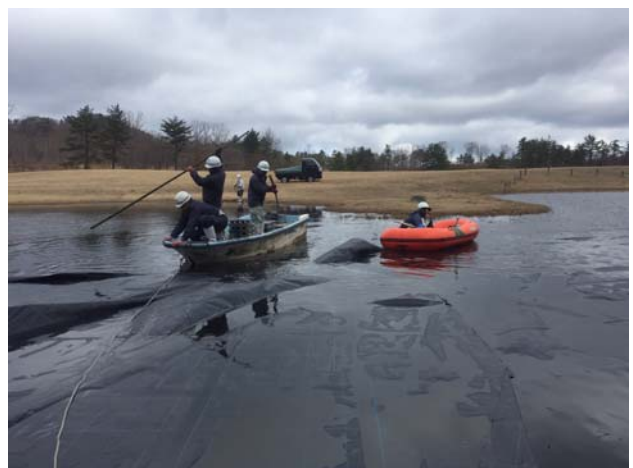
シートの設置作業
